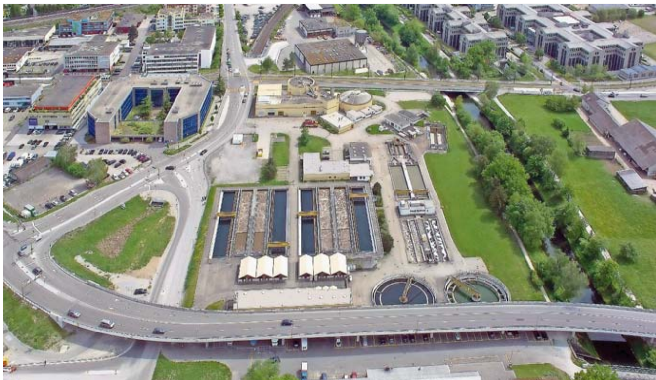
Kaum zusätzlicher Platz: Die neuen Reaktorbecken der AKO werden direkt auf den bestehenden gebaut.
