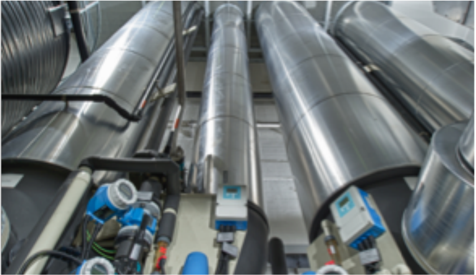
Abb. 8: Stickstoffrückgewinnungsanlage (NRG)
