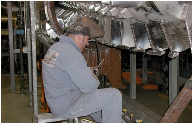
Schweissarbeiten am Trockner 2
