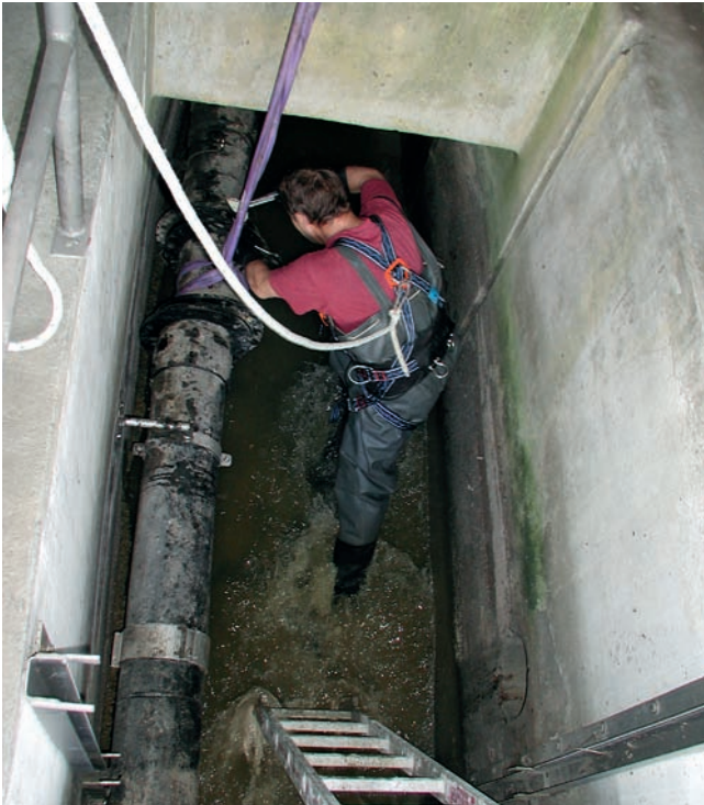
Demontage Rohrleitung
