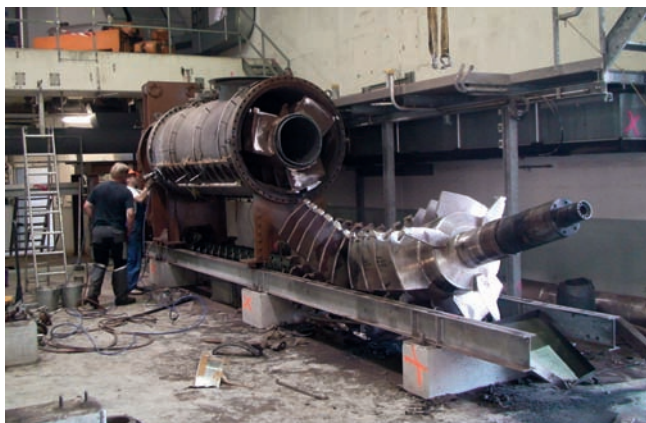
Abbruch eines Schlammrockners
