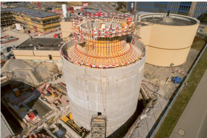
Rohbau Faulturm 1. Im Hintergrund der alte Faulturm, welcher zum Stapelbehälter umfunktioniert wird
