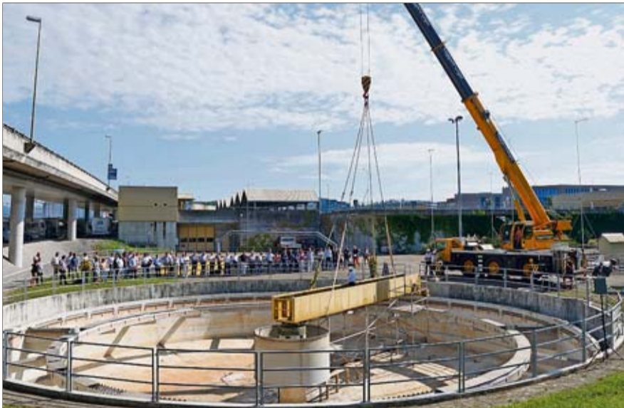
Rund 60 Gäste verfolgten den Beginn der Bauarbeiten.
