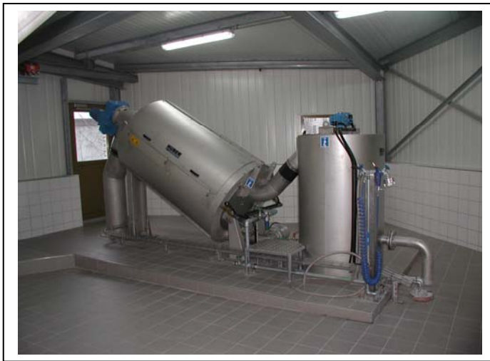
Abbildung 12: ÜSS-Entwässerung
