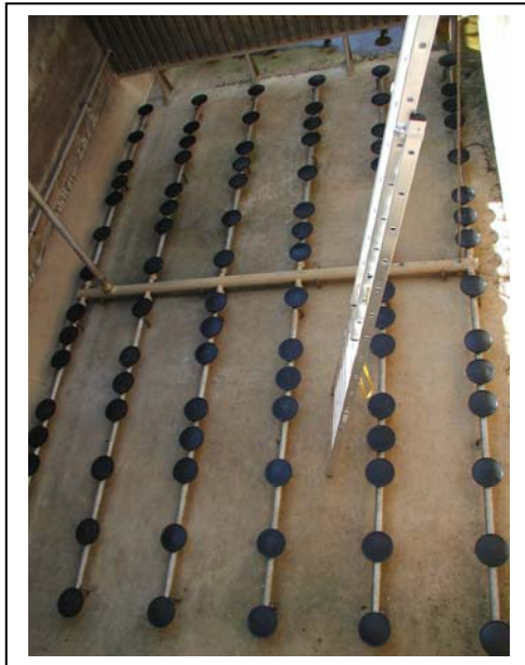
Abbildung 11: Belüftungsbecken mit neuen Membranbelüftern
