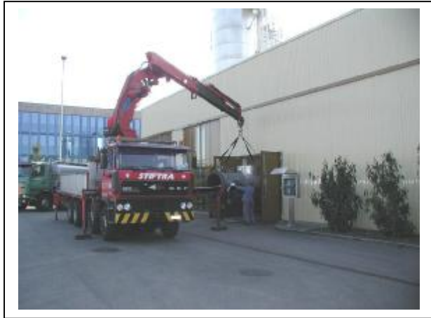
Abbildung 10: Abtransport Trocknerteil
