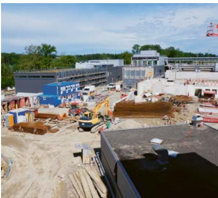
Gesamtübersicht der Baustelle ohne Schlammbehandlung.
