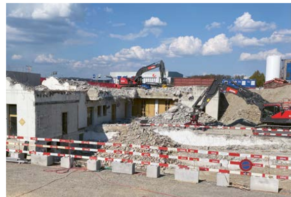
Rückbau des Obergeschosses des ehemaligen Verwaltungsgebäudes. Das Erdgeschoss mit Garage, Archiv und Lagerräumen bleibt bestehen.
