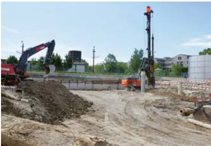
Hinter dem Kran entsteht die Baugrube für die neue Schlammbehandlung.
