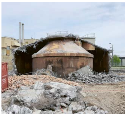
Rückbau des alten Faulturms mit innenliegendem Schlammstapel von 1961.
