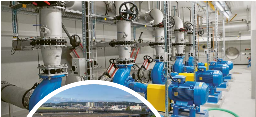
Pumpenraum für die neue Biologiestufe (Nereda®).
